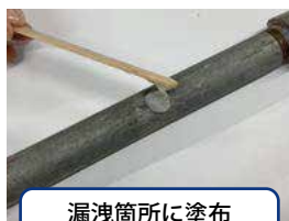
漏洩箇所に塗布
