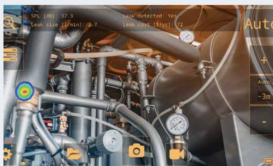
配管からの圧縮気体漏れの点検に
