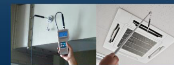
空調機器の能力試験・保守点検
